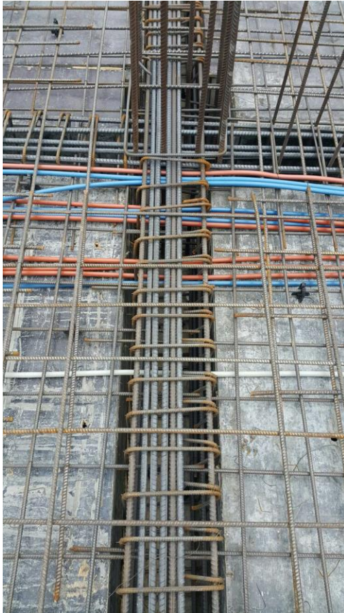
Şekil 1 Etriye yardımıyla birbirine kenetlenen kiriş donatısı
