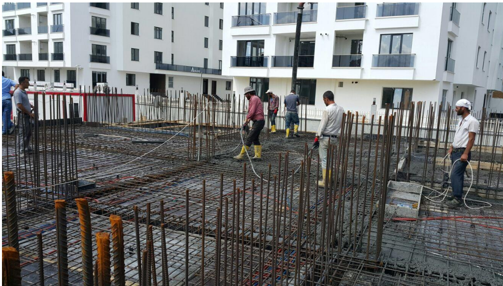
Şekil 2 Beton dökümü ve betonun vibratör yardımıyla sıkıştırılması
