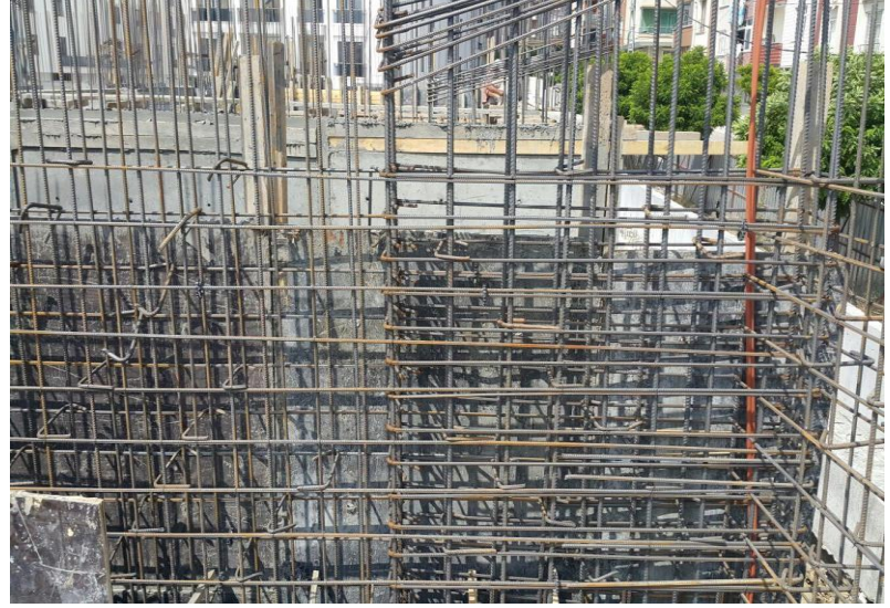
Şekil 2 Düşey donatılarda kullanılan çiroz bağlantıları
