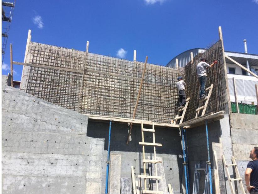
Şekil 1 Perde duvar donatılarının yerleştirilmesi
