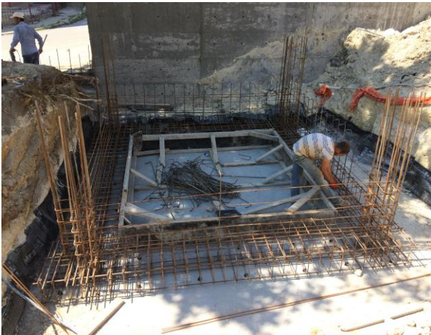
Şekil 2 Papuç temel için donatıların yerleştirilmesi
