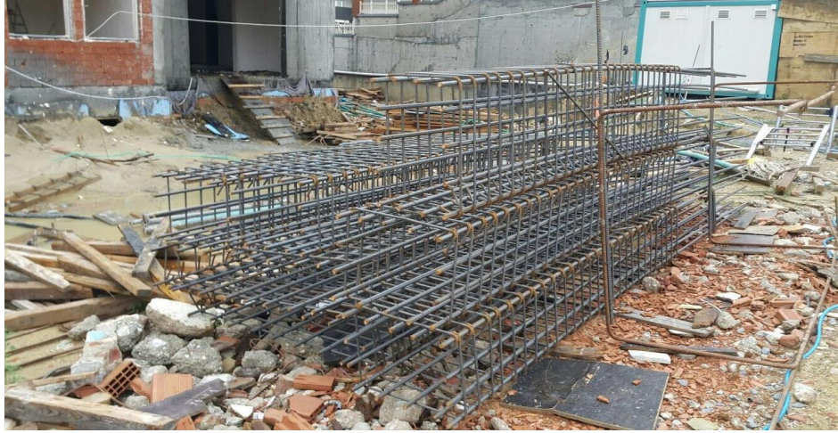
Şekil 1 Kolon için sahada hazırlanan demir donatılar
