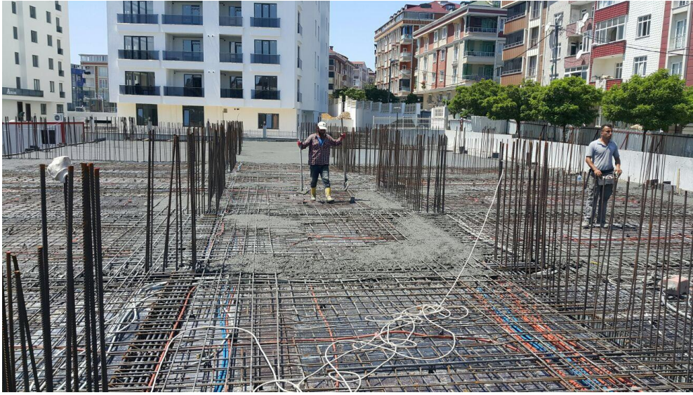
Şekil 1 Kolonlarda fazladan bırakılan demir filizler
