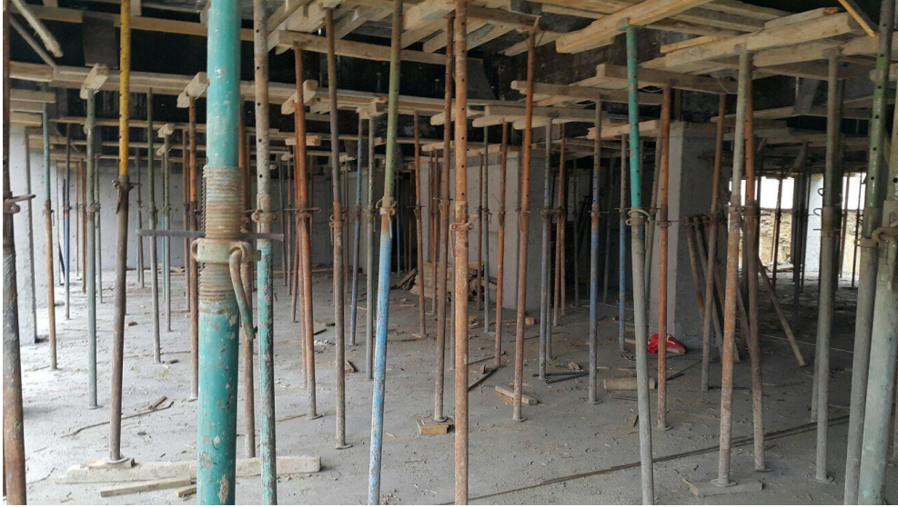
Şekil 1 Döşeme kalıplarına alttan destek sağlayan teleskopik direkler
