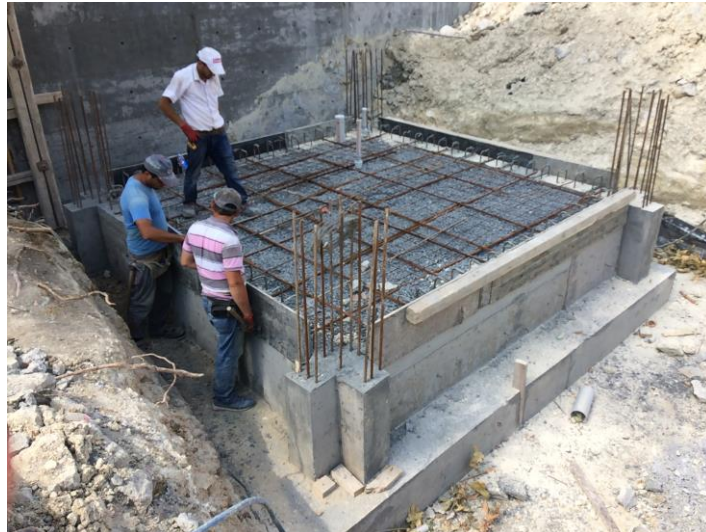
Şekil 3 Bekçi kulübesi dolgu ve hasır döşeme işlemi
