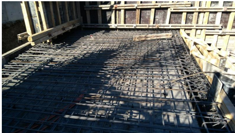
Şekil 3 Donatıları yerleştirilen merdiven sahanlığı
