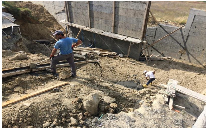
Şekil 2 Temel öncesi tesviye işlemi (grobeton dökümü)
