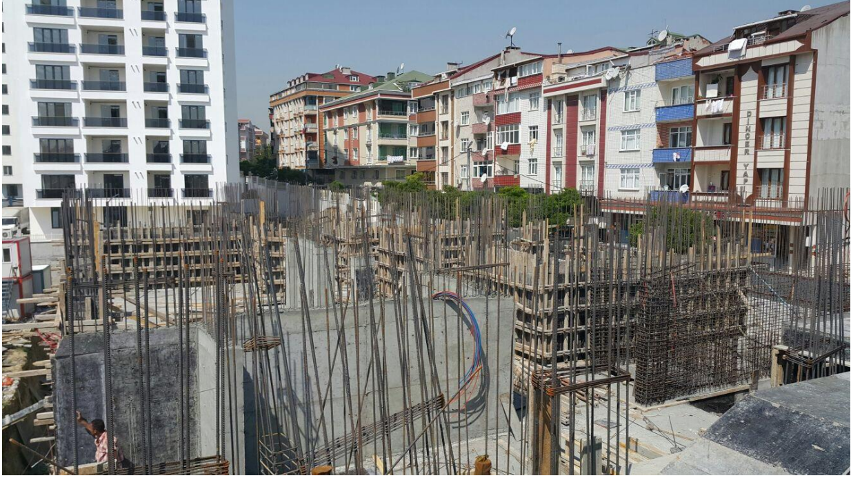
Şekil 1 Zemin kattaki kalıp işlemleri
