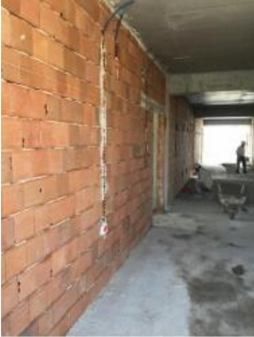
Şekil 1 İç duvar imalatı
