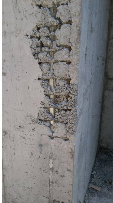
Şekil 1 Segregasyon hatası
