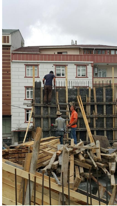
Şekil 2 Betonun boşluksuz yerleşmesi için vibratör kullanılması
