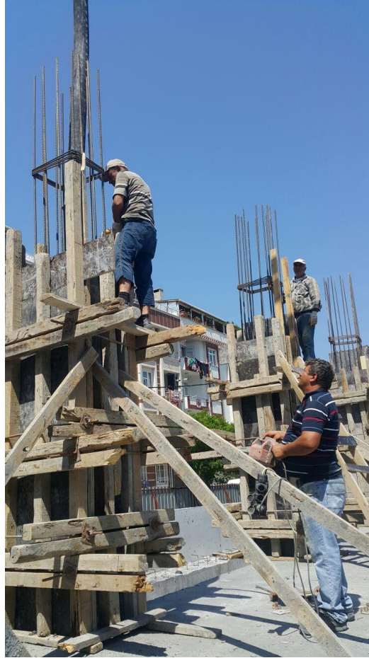
Şekil 1 Kolonlara beton dökümü
