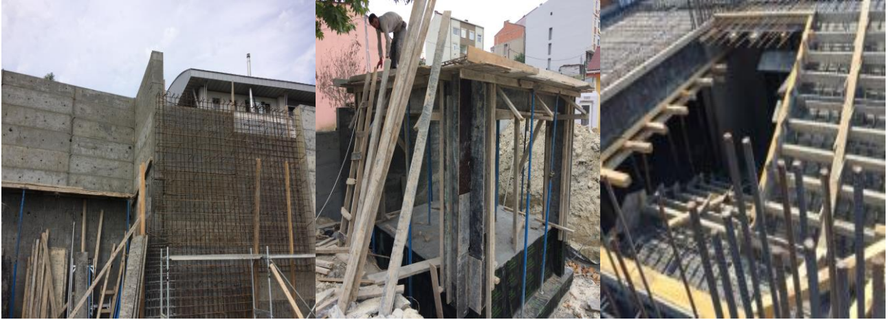
Şekil 1 Sırasıyla perde donatıları, bekçi kulübesi döşeme imalatı ve merdiven donatı ve kalıpları
