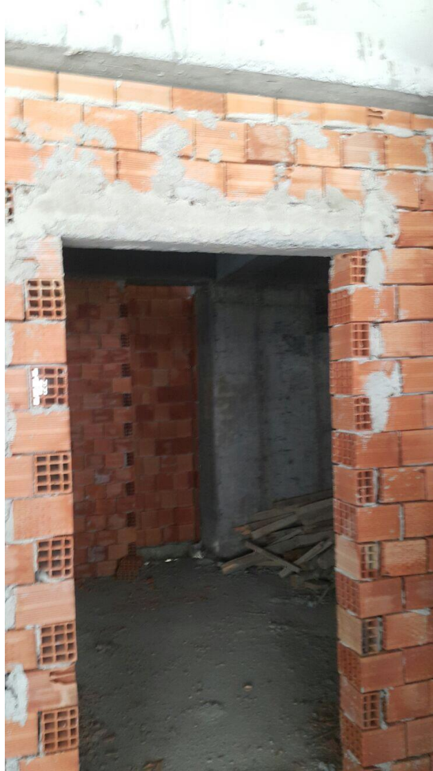
Şekil 1 Üzerlerine binen yükü karşılamak için kapı üstüne konan betonarme lento
