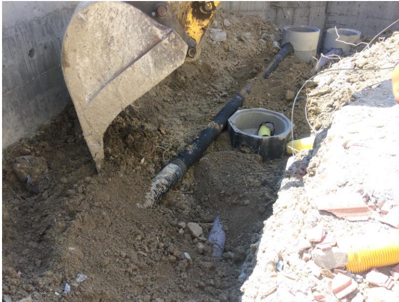
Şekil 2 Zemin altı drenaj ve koruge borularının yerleştirilmesi
