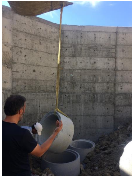
Şekil 3 Alt yapı çalışmasında bacaların yerlerine yerleştirilmesi
