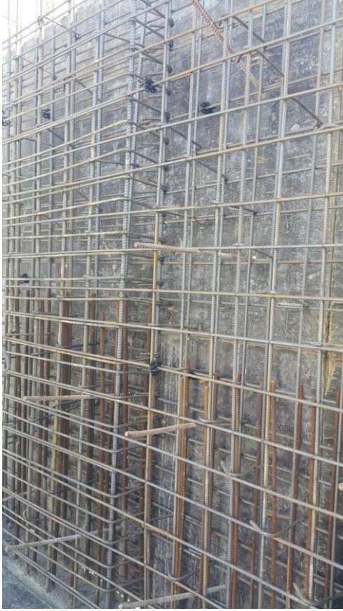
Şekil 1 Donatılarda bırakılan paspayı
