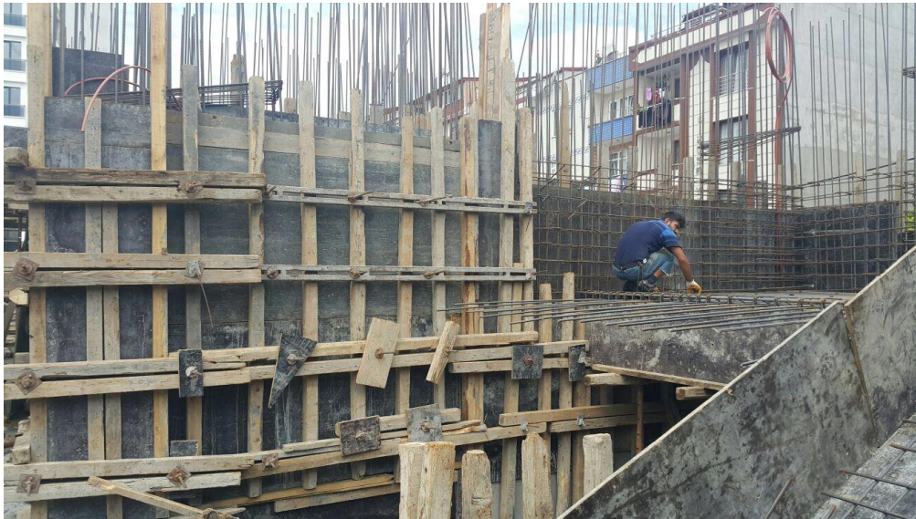
Şekil 2 Merdiven demirlerinin yerleştirilmesi
