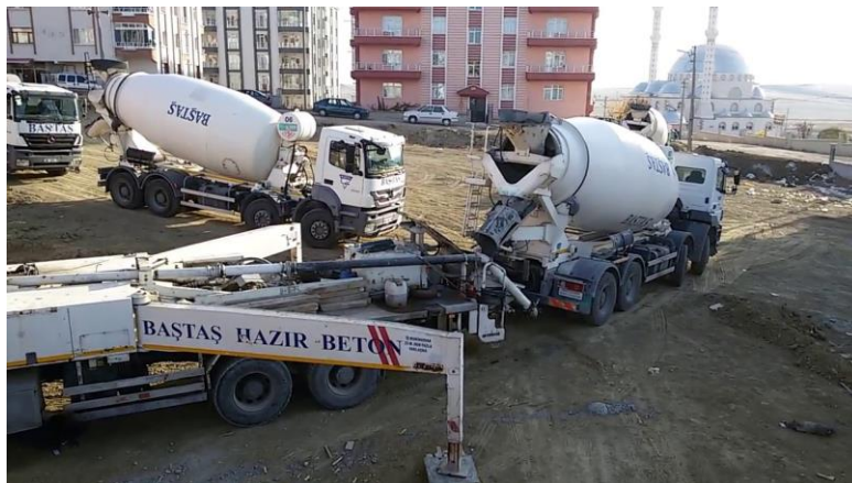
Şekil 2 Mikserlerden beton pompasına beton aktarılması
