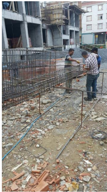
Şekil 3 Kolon için hazırlanan demir donatılar
