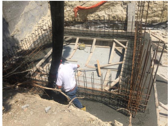
Şekil 3 Kalıpları hazırlanan temele beton dökümü
