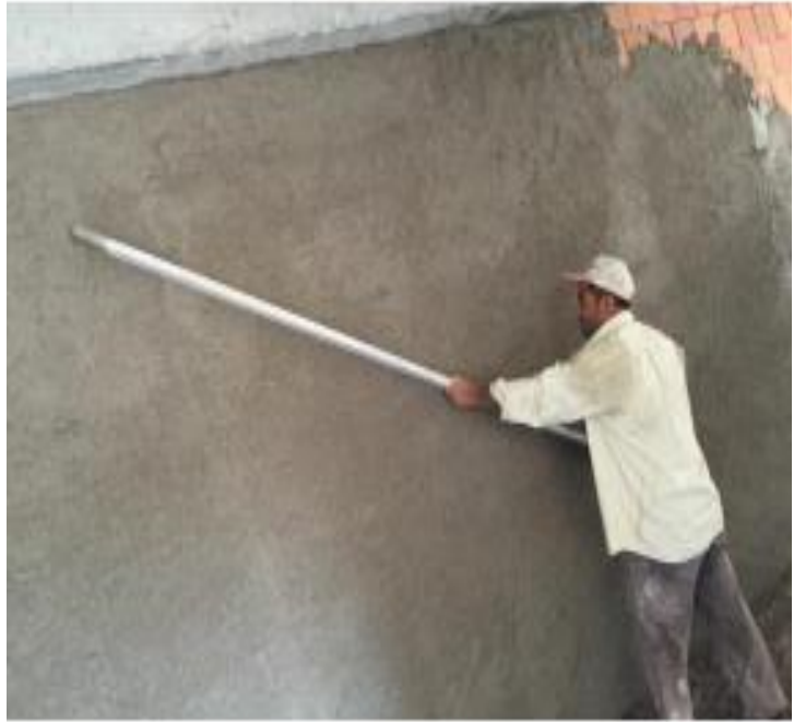
Şekil 2 Kaba sıva imalatı
