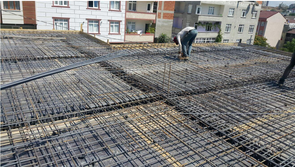
Şekil 2 Döşeme donatıları ve donatıların altına bırakılan paspayı (pas taşları)
