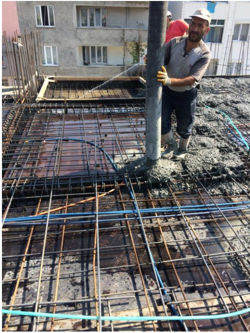
Şekil 1 Kiriş ve döşemelere beton dökülmesi
