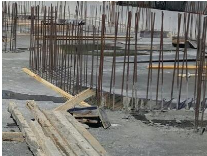
Şekil 2 Üstüne bindirme yapılacak olan kolon filizleri
