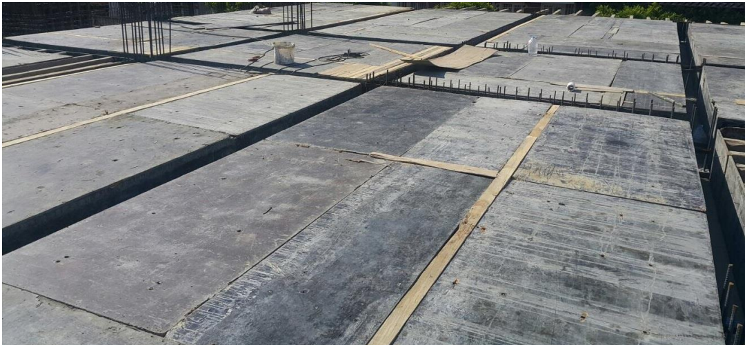
Şekil 2 Döşeme ve kiriş kalıplarının yerleştirilmesi
