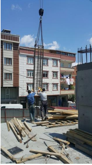
Şekil 1 Demir donatılarının yerleştirilmesi
