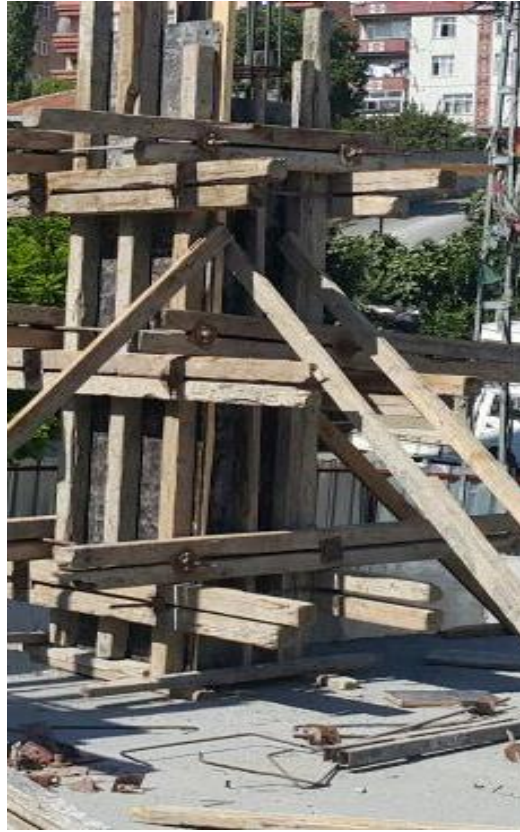
Şekil 1 Kolon kalıpta bulunan kanat, kuşak ve göğüsleme yapı elemanları
