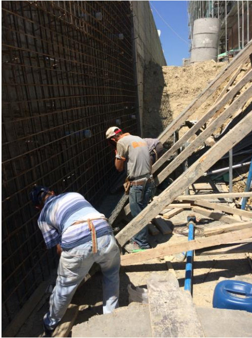
Şekil 1 Perde duvar kalıp ve donatılarının yerleştirilmesi
