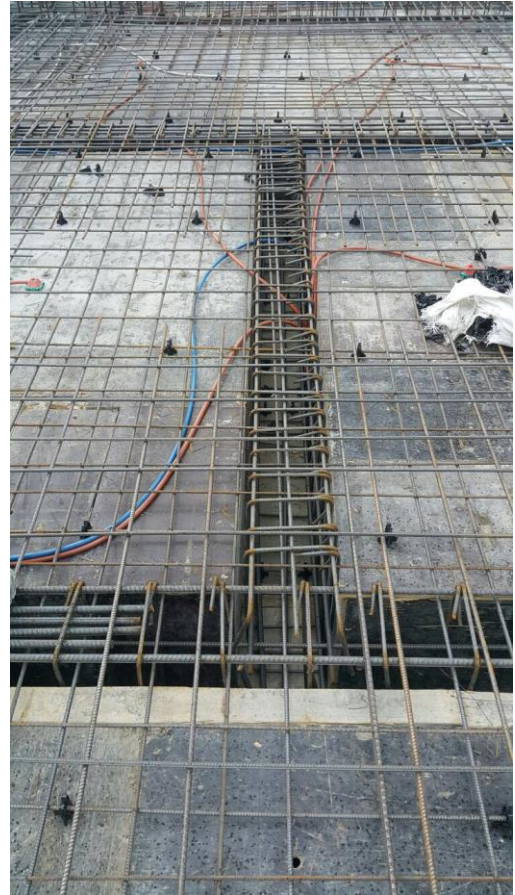
Şekil 2 Beton dökümüne hazır hale getirilen tabliye
